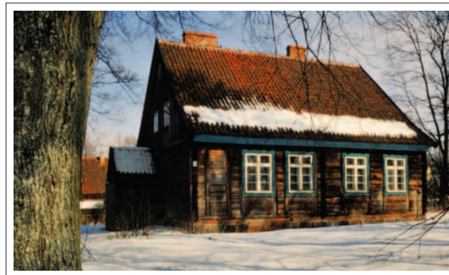
Budynek nr 26 – lata 90.
