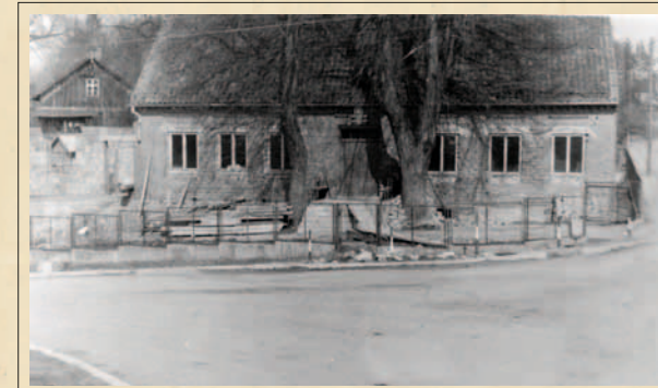
Budynek szkoły podczas remontu w 1982 r.
