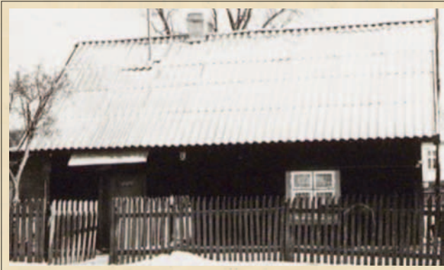
Budynek nr 70 rozebrany w roku 2022
