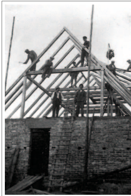
Budowa domu – numer obecny 63
