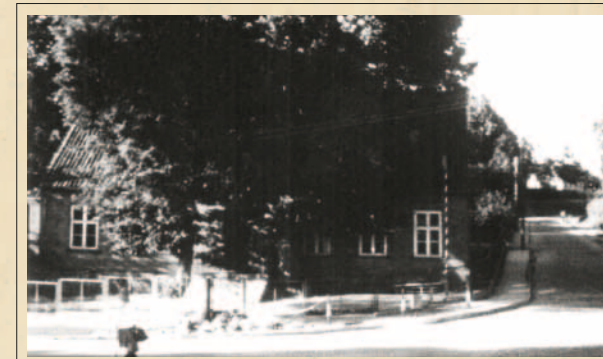
Budynek szkoły, inne ujęcie
