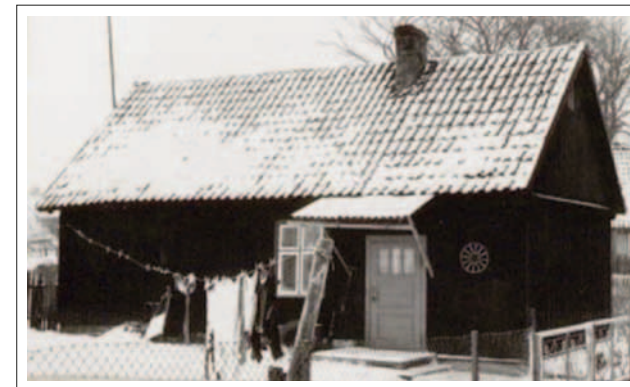
Nieistniejący już budynek nr 60
