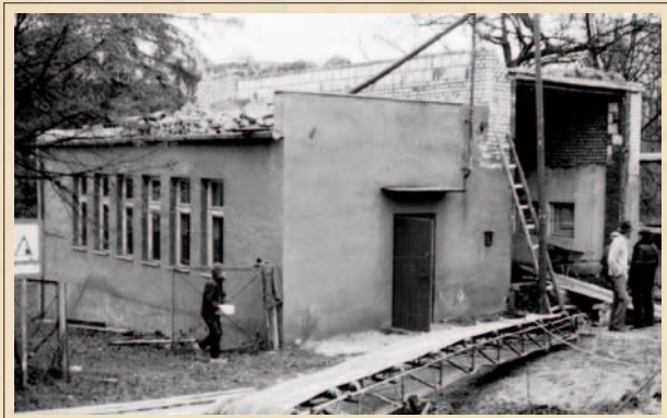
Rozbudowa remizy, rok 1987
