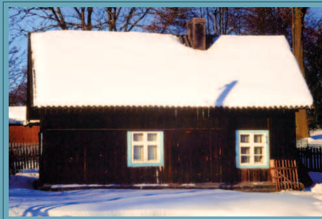
Drewniany budynek rozebrany w 2022 roku – 2016
