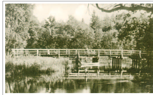
Most drewniany niedaleko ujścia rzeki z Jeziora Krutyńskiego
