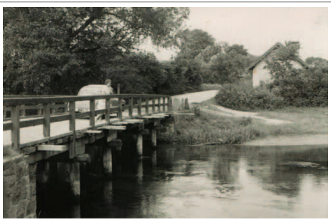
Most drewniany w Rososze od strony rzeki – lata 60.
